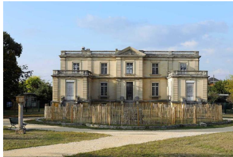
Réhabilitation du Château des Arts et construction d'une nouvelle école de musique et de danse
